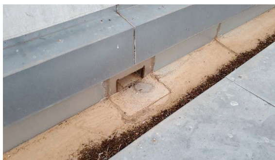
Mòdul 2 zona canal recollida aigua que genera filtracions
