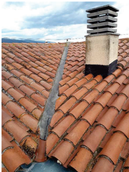
Mòdul 2 aiguafont a vora cantonada exterior
