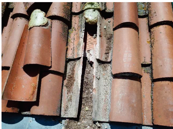
Inspecció de zona de teules trencades. S'observa el tauler ceràmic de suport
