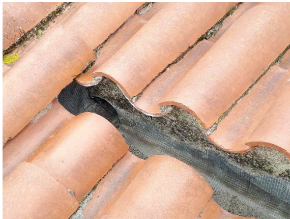
Mòdul 2 detall canal recollida aigua zona rampa
