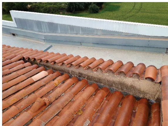
Mòdul 2 detall canal recollida aigua zona rampa
