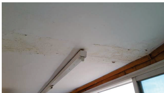
Cel ras del passadís sota pas/canal del mòdul 2 que pateix filtracions
