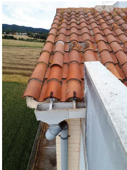
Mòdul 2, canal a vora cantonada exterior
