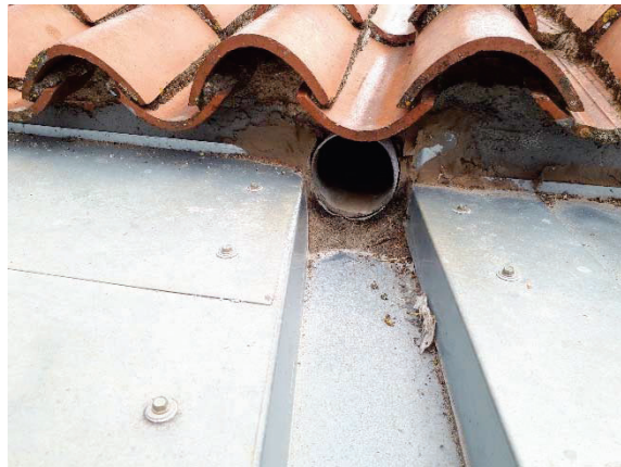
Mòdul 2 detall sortida a pas/canal de recollida aigua zona rampa
